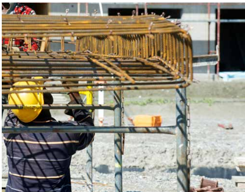
Travaux de ferrailage et de préparation au bétonnage sur un chantier de génie civil / Bewehrungsarbeiten und Vorbereitungen für die Betonierung auf einer Baustelle © Etat du Valais - François Perraudin
