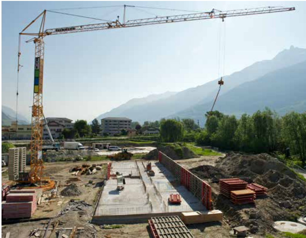
Chantier de plaine en cours de construction / Talsohlenbaustelle © Etat du Valais - François Perraudin
