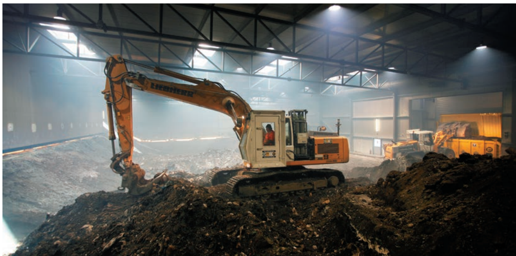
Les travaux d'assainissement de l'ancienne décharge du Pont Rouge à Monthey prévoient l'excavation de 70'000 m 3 de déchets et 50'000 m 3 de terres de contact Die Arbeiten zur Sanierung der früheren Deponie Pont Rouge in Monthey beinhalten das Abtragen von 70'000 m 3 Abfall und 50'000 m 3 kontaminierter Erde
