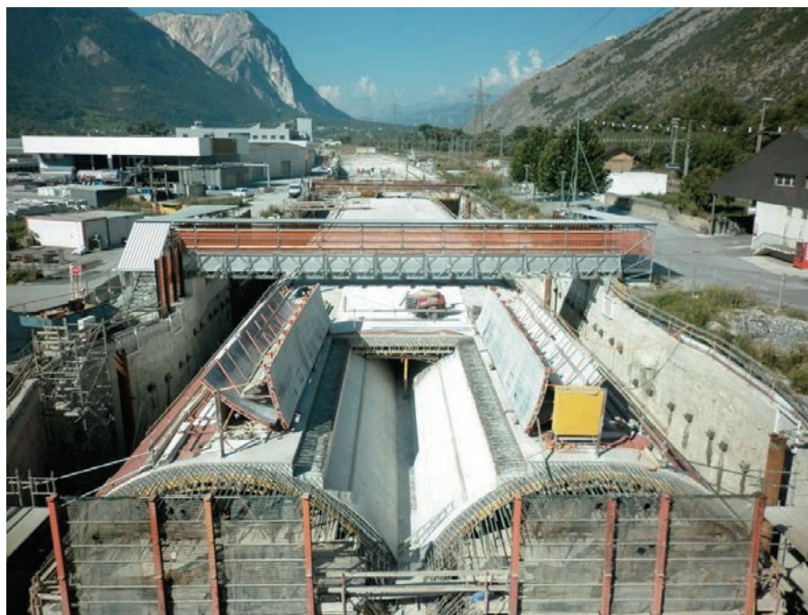
L'A9 totalise 31.8 km entre Sierre et Viège. Son tracé est couvert à 50 % (tunnels ou tranchées couvertes). Quelque 300 collaborateurs s'y activent. Die A9 ist zwischen Siders und Visp 31.8 km lang. 50 % der Strecke ist überdeckt (Tunnels, gedeckte Einschnitte). 300 Mitarbeiter sind beschäftigt.
