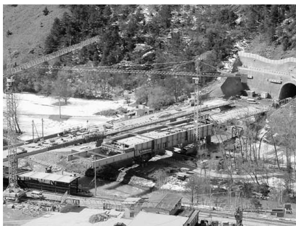
Le chantier des ponts sur la Vispa à Staldbach
