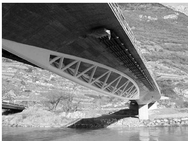
Le pont sur le Rhône à Branson, axe Martigny-Fully
