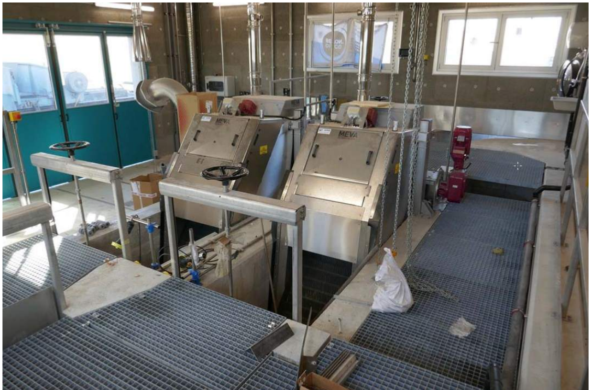
Figure 22 Nouveaux tamiseurs STEP de Vétroz-Conthey
