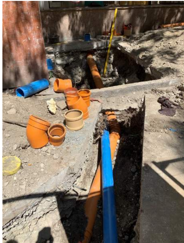
Figure 10 : Mise en séparatif d'une rue à Sion
