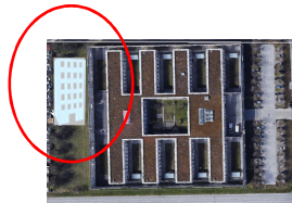
Neues Gebäude am Standort des Gefängnisses Sion Kapazität: 20 Plätze (18 Männer und 2 Frauen)
