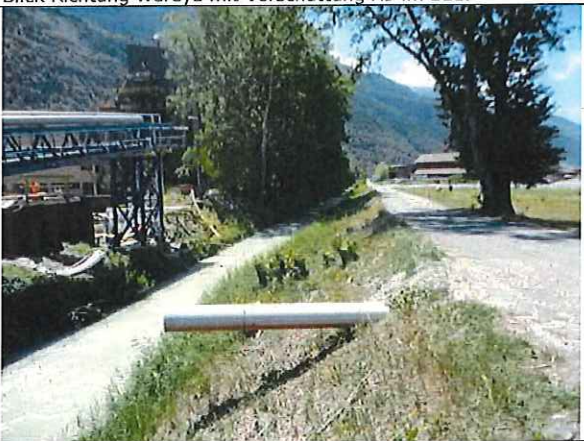
GGK im Bereich ARA Visp mit Leitungsverlegung durch A9.
