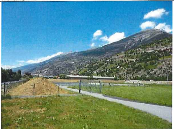
Rückhaltebecken Lonza AG (seit 2001/02)
