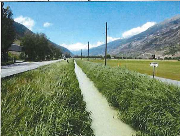
Bereich Grosseia, GGK entlang T9, Gasleitung in Unterhaltspiste mit Belag
