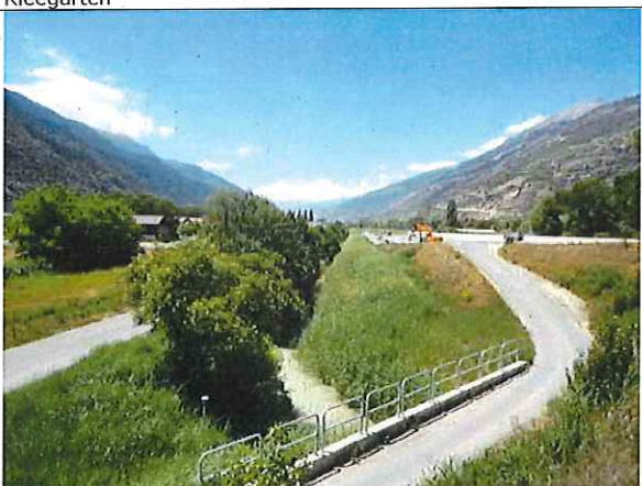
Blick Richtung Wereya mit Vorschüttung A9 im Bau.
