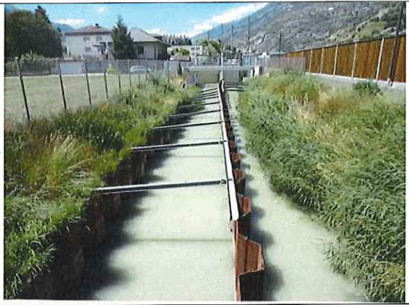
Nord- und Südkanal nach Querung Kleegärtenstr., Blick Richtung Schleuse
