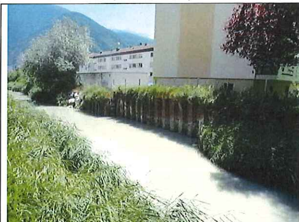
Stabilisierung Böschung mit Spundwände im Bereich Kleegärten
