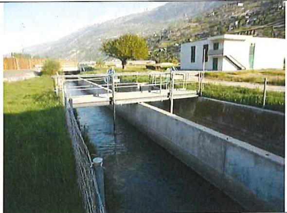
Nord- und Südkanal (getrennt mit Betonwand)
