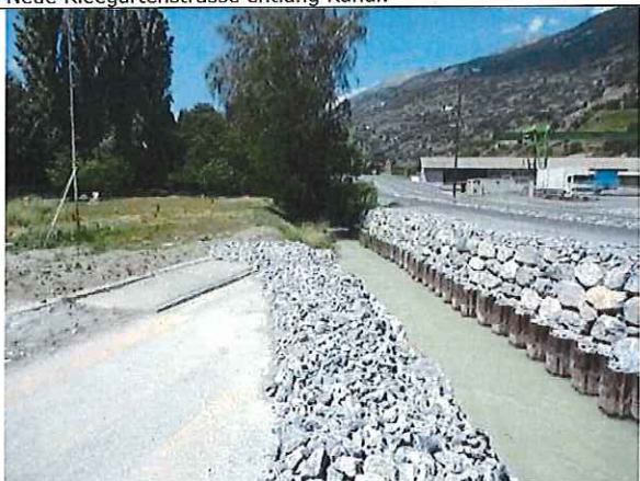
Stabilisierung Böschung mit Spundwände/Blockwurf im Bereich Kleegärten
