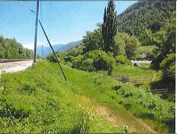
Bahndamm entlang dem GGK, Bereich Niedergesteln
