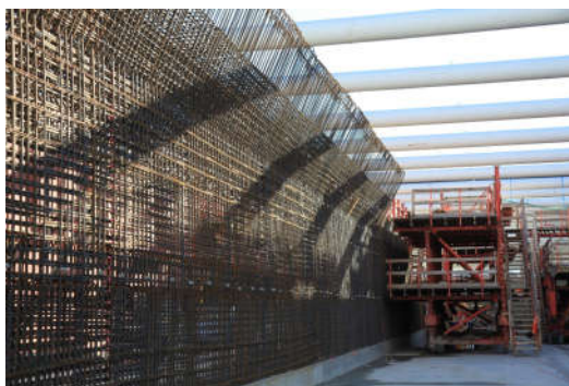
Herstellung Mittelwand mit Werkleitungskanal / Elévation centrale avec galerie technique en cours de construction
