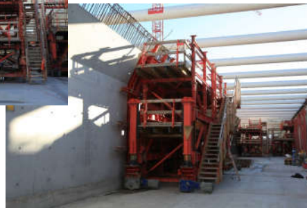
Herstellung Mittelwand mit Werkleitungskanal / Elévation centrale avec galerie technique en cours de construction
