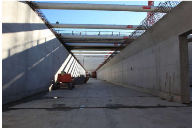
Tunnelröhre Nord ohne Deckenabschluss / Tube Nord avant bétonnage de la dalle
