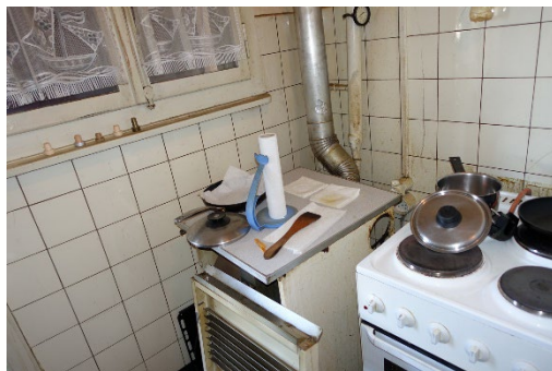
Chaudière hors service
