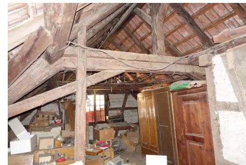
Combles et toiture
