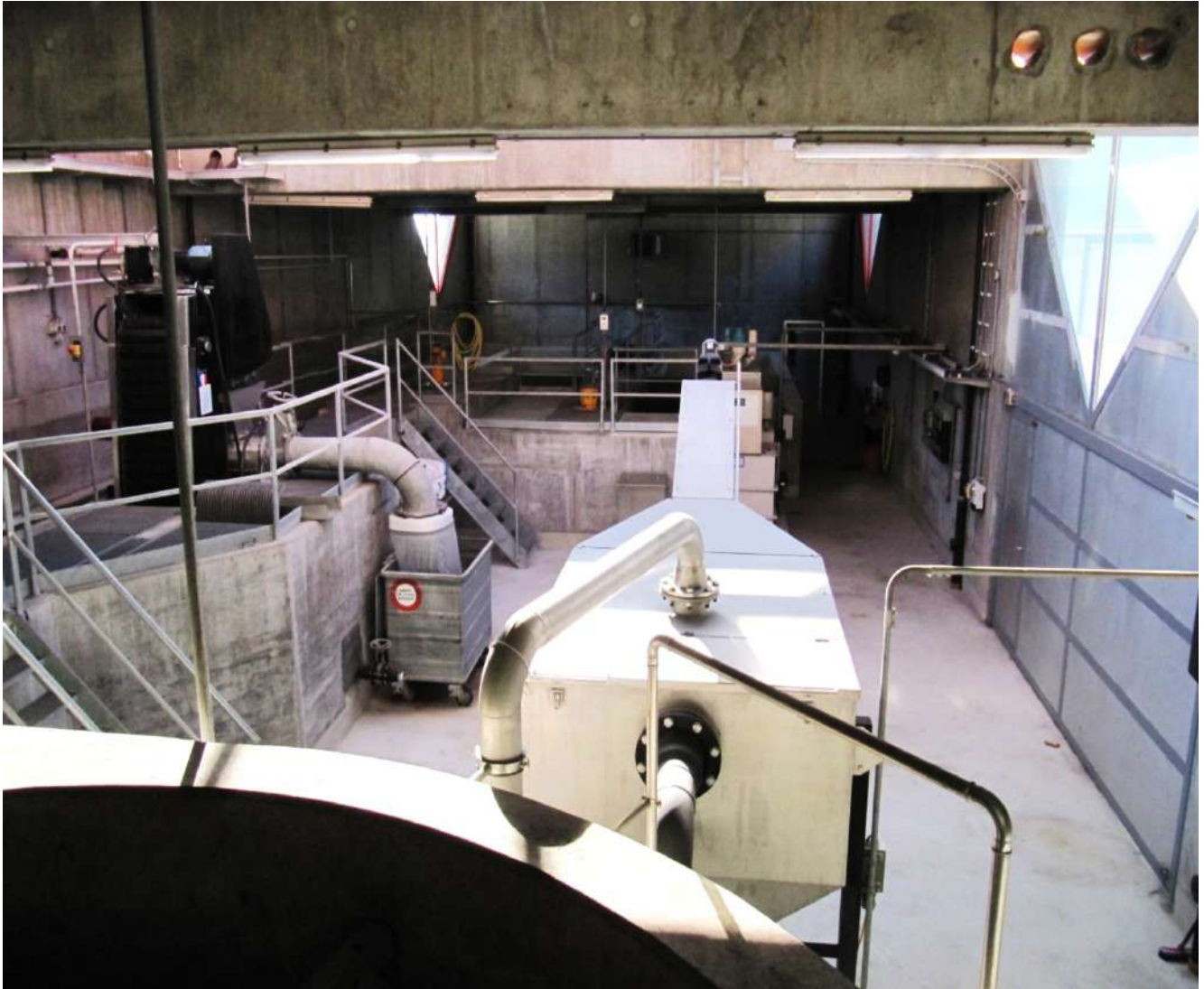
STEP/ARA Riddes, mechanische Reinigungsstufe © SEN/DUW
