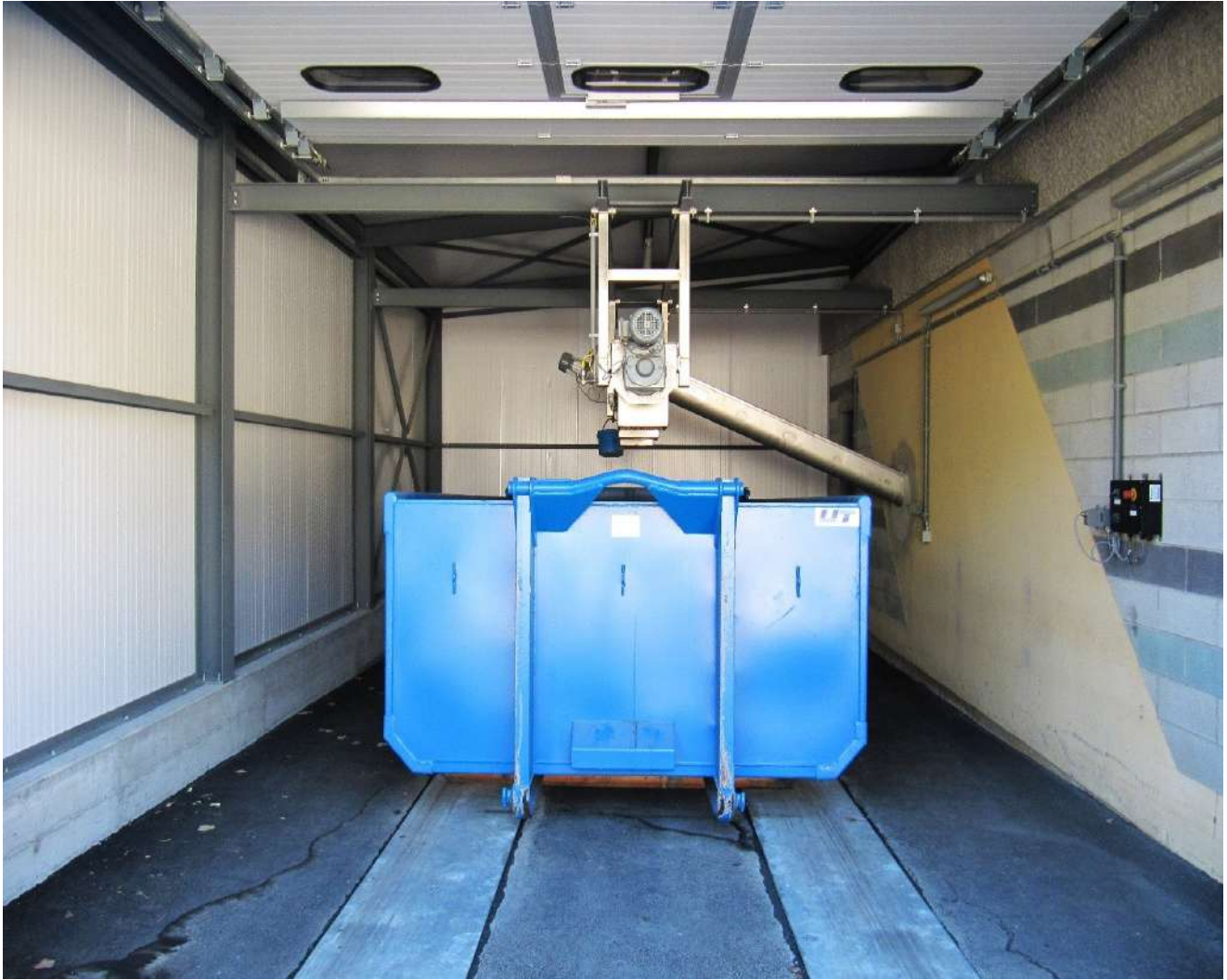
STEP/ARA Riddes, Beladezone für den entwässerten Schlamm © SEN/DUW
