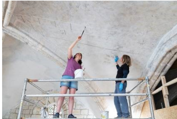
FIGURE 1 – Restitution du décor à faux joints sur les voûtes de la basilique de Valère par les restauratrices du consortium Guyot et James, 2021. (Photo : © Michel Martinez et Bernard Dubuis, Centre de documentation de la Cible)(ci-après CDC)
