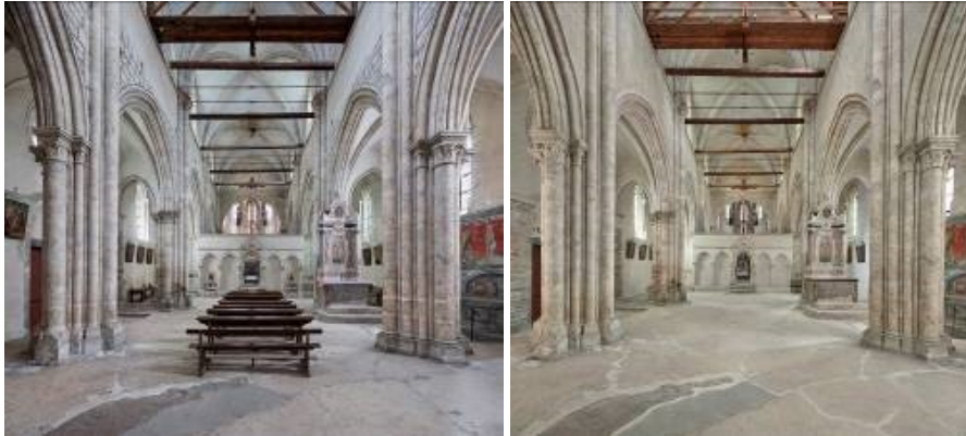
FIGURE 3 – Basilique de Valère, Sion, avant la restauration des murs (2019) et après leur restauration (2022). Vue vers le chœur depuis la nef. (Photos : © Michel Martinez et Bernard Dubuis, CDC)
