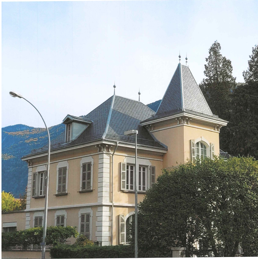
Figure 9 – Maison Paul de Cocatrix, après restauration, 2022. (Photo : © L. Closuit, Etat du Valais, SIP, MH)
