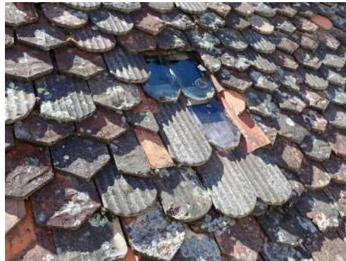
FIGURE 33 – Détail du pan ouest de la toiture de l'aile orientale du château d'Hauteville, ajouré par des tuiles en verre à pointe montheysannes. (Photo : Michèle Grote, 2020)
