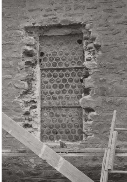
FIGURE 34 – Détail d'une photographie de P[ierre?] Margot montrant l'ancienne baie du mur gouttereau nord de l'église de Saint-Pierre-de-Clages (quatrième travée depuis l'ouest) avec de petites cives montées sur plomb, avant 1948. (Bibliothèque nationale suisse, Archives fédérales des monuments historiques, Documentation de restaurations et de fouilles, EAD-84625)
