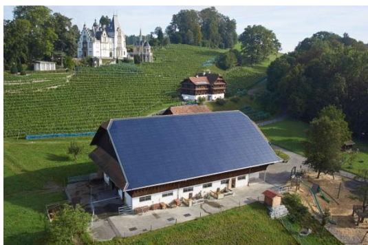
Illustration 8 : château de Meggenhorn (inventaire ISOS, assorti d'un objectif de sauvegarde A), Meggen (LU). Grange avec modules photovoltaïques de 100 kW / 580 m 2 intégrés sur l'ensemble de la surface. © Prix Solaire Suisse 2014
