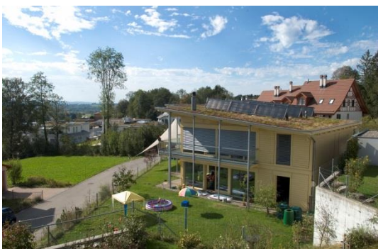
Illustration 5 : installation solaire thermique sur toit plat s'élevant à plus de 20 cm au-dessus du toit.. Autorisation de construire requise en bonne et due forme, dans la mesure où le champ d'application de la procédure d'annonce n'a pas été étendu par le canton. © Swissolar
