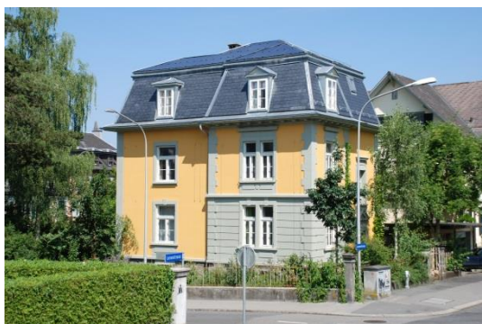
Illustration 7 : maison Hutterli / Röthlisberger, Berne : bien à protéger d'importance cantonale, installation photovoltaïque de 2,7 kW et capteurs solaires sous les panneaux en ardoise naturelle. © Prix Solaire Suisse 2014
