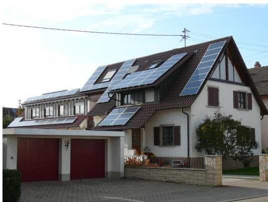
Illustration 2 : panneaux photovoltaïques ne constituant pas « une surface d'un seul tenant ». Photographie prise en Allemagne.
