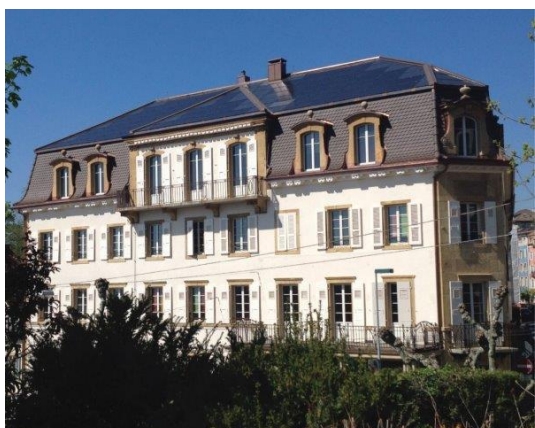
Illustration 9 : hôtel des Associations, Neuchâtel, dans le quartier du Tertre, inventaire ISOS, assorti d'un objectif de sauvegarde A. Installation photovoltaïque de 28 kW intégrée à la toiture. © Prix Solaire Suisse 2015
