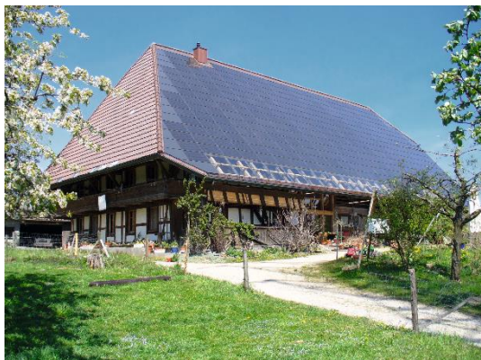
Illustration 1 : panneaux photovoltaïques installés sur une surface entière et « d'un seul tenant », qui répondent à toutes les exigences d'intégration énoncées à l'art. 32a, al. 1, OAT. © Prix Solaire Suisse 2011
