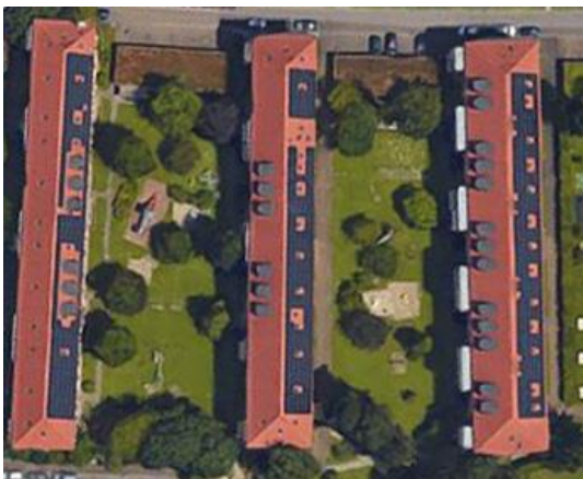
Illustration 3 : panneaux photovoltaïques sur toit dans le lotissement de la Holestrasse à Bâle, surface d'un seul tenant avec des découpes autorisées pour les lucarnes. Photographie provenant de google earth.
