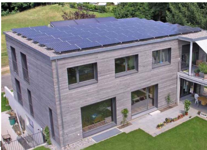
5.5.4 PV-Anlage auf dem Flachdach eines Einfamilienhauses:
