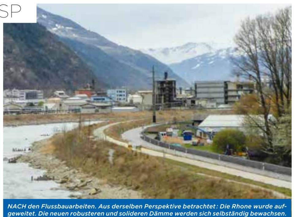
NACH den Flussbauarbeiten. Aus derselben Perspektive betrachtet: Die Rhone wurde aufgeweitet. Die neuen robusteren und solideren Dämme werden sich selbständig bewachsen.
