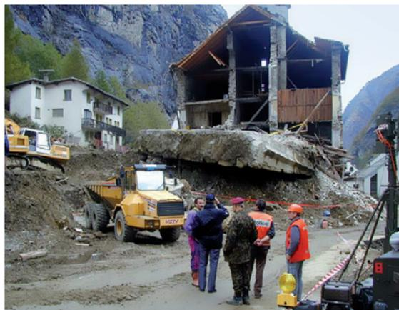
Bei den katastrophalen Überschwemmungen von 2000 wurde eine Seite des Stockalperturms von Gondo zerstört. Die Instandsetzung des ab 1666 erstellten Bauwerks kostete fast 8 Millionen Franken und dauerte 7 Jahre.
