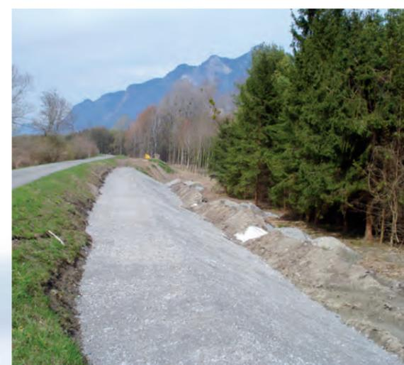
Dammverstärkung in der Industriezone von Aigle. Die Rhone befindet sich links im Bild. Durch eine Hinterfüllung mit Sickermaterial (Mischung von Erde und Kies) wurde der bestehende Dammkörper verstärkt, der früher zu schmal und zu steil war.
