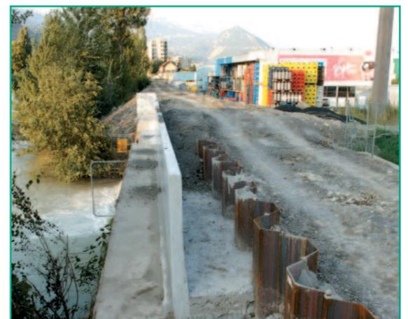
Sitten, Ende August, auf dem linken Rhoneufer flussaufwärts von der Autobahn (Aufnahme in Richtung St-Marguerite-Brücke). Inzwischen wurden die hier noch herausragenden Spundwände mit Erde zugeschüttet und die Arbeiten abgeschlossen.
