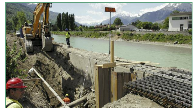
Eine Spundwand aus Stahlplatten wird acht Meter tief in dem Damm getrieben. Bei Leitungsquerungen (hier die Gasleitung) erfolgt die Verstärkung mittels Betonmauer.
