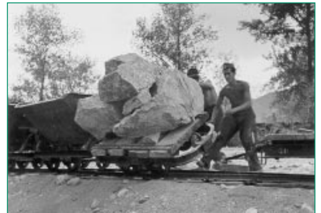
2. Korrektion: Blöcke zum Schutz des Ufers.
