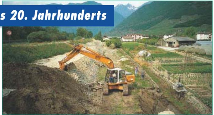
Fully: Verstärkung eines Rhonedamms und Verbesserung der Drainage.
