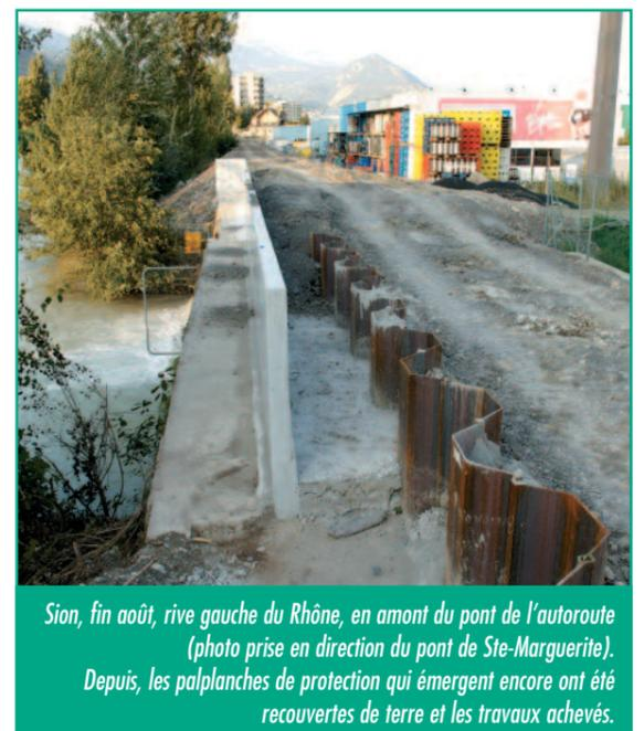
Sion, fin août, rive gauche du Rhône, en amont du pont de l'autoroute (photo prise en direction du pont de Ste-Marguerite). Depuis, les palplanches de protection qui émergent encore ont été recouvertes de terre et les travaux achevés.
