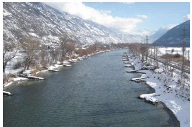
Photo 3 : Epis de la première correction du Rhône à Turtmann (février 2005).
