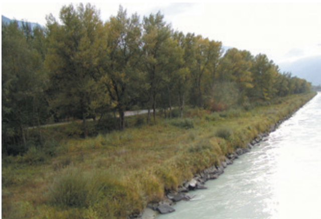
Photo 4: Lit majeur construit lors de deuxième correction du Rhône à Fully (sept. 2004).
