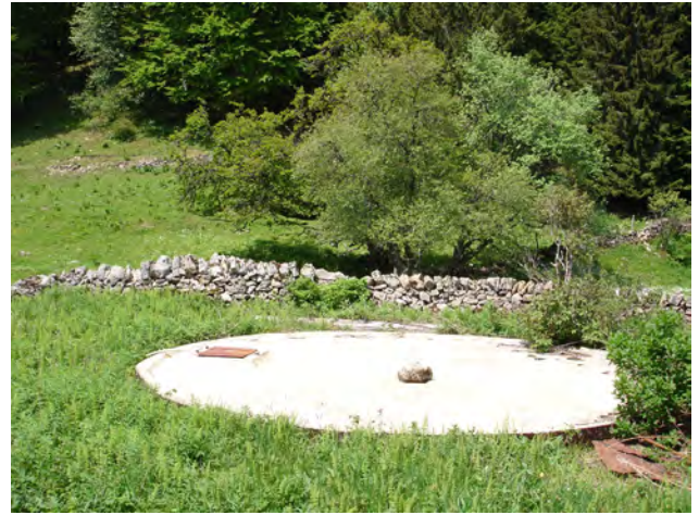
Récupération sur une dalle en béton sise dans un périmètre enclos (citerne combinée).
