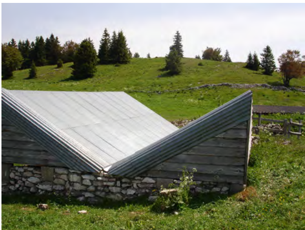
Récupération sur un couvert inversé (meilleure récolte de l'eau lors d'orages, retient mieux la neige, mais problèmes dus au vent).
