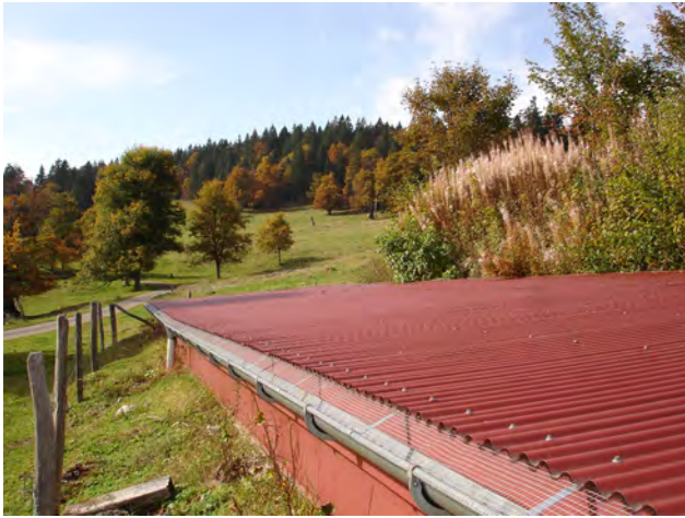
Récupération sur un couvert inversé (meilleure récolte de l'eau lors d'orages, retient mieux la neige, mais problèmes dus au vent).
