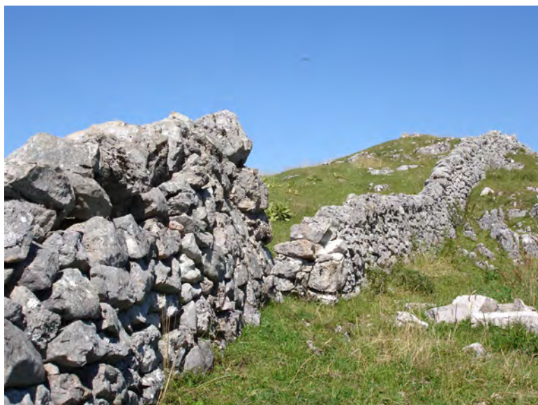
Mur en pierres sèches
