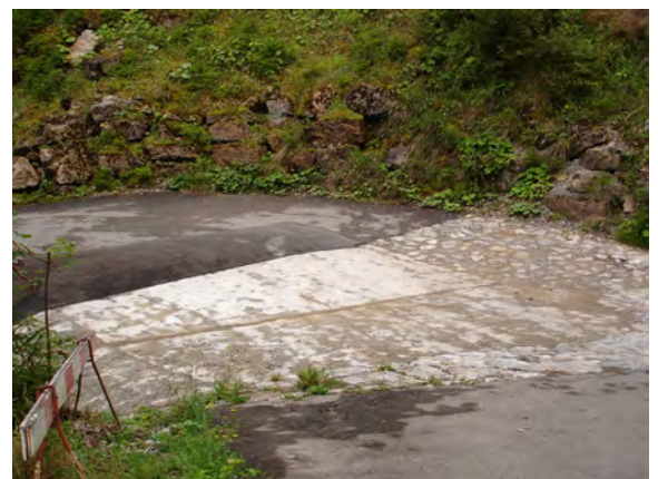
Gué avec dalle en blocs cimentés
