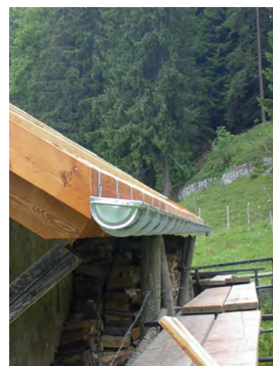
Raccord toit-chéneau
