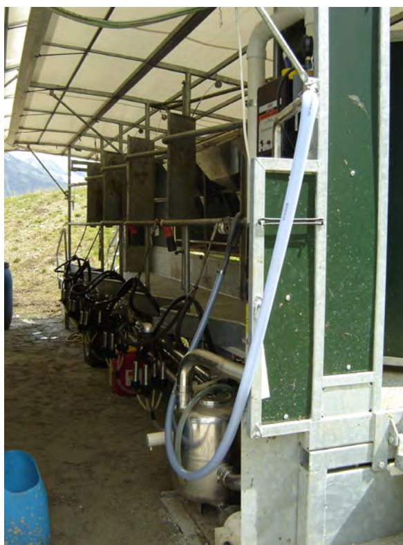
Alpage du Marais, installation de traite, vue intérieure
