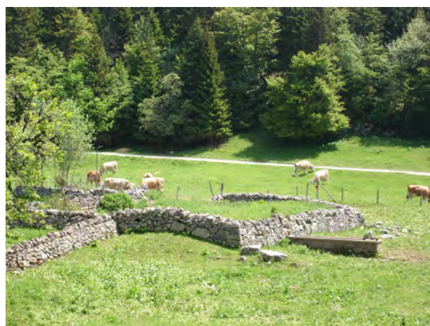
Bassin et mur en pierres sèches
