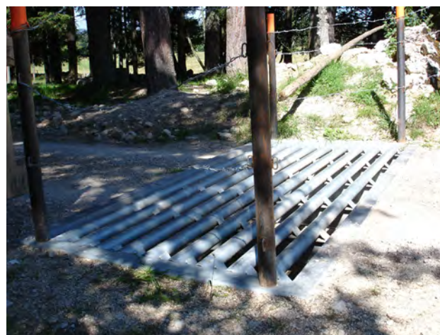
Clédar canadien avec 4 tubes pour clôture
