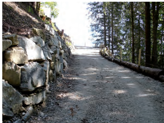
Chemin gravelé, enrochement et billons
