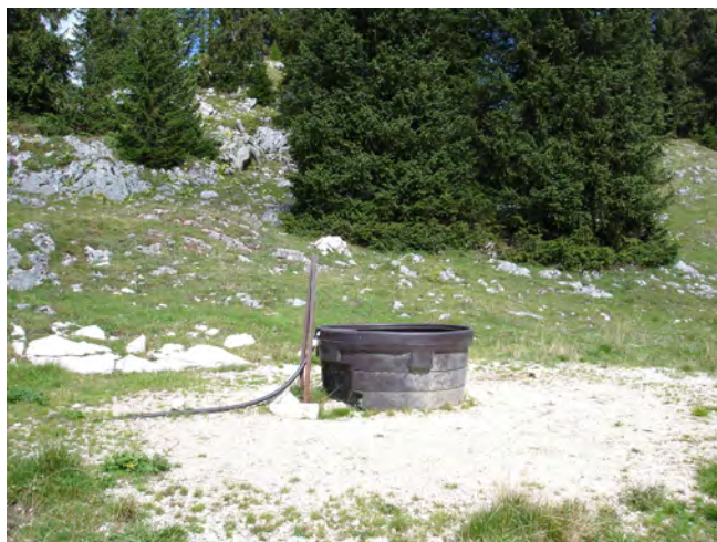
Bac avec accès gravelé
