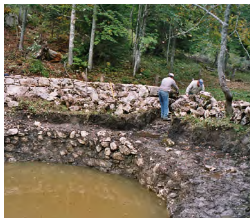
Puits en cours de réfection
