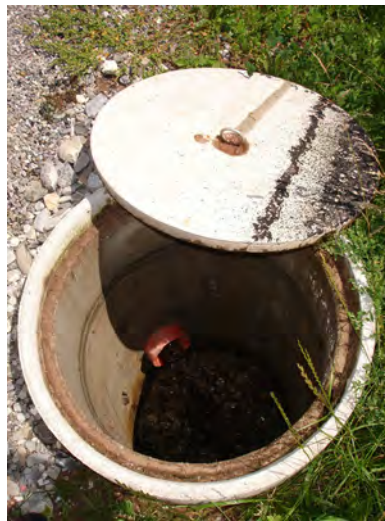
Regard sur drainage
