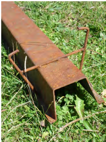
Rigole alpine métallique avec pattes de scellement
