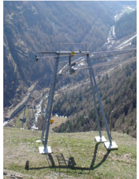
Tann Schweiben, pylône
