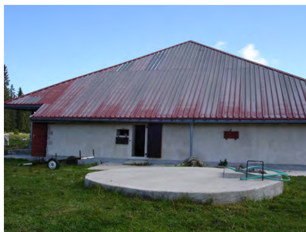
Réception des eaux en toiture et citerne
