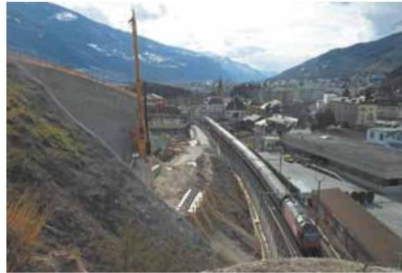
L'actuel tunnel du Gobet, construit en 1877, ne permet pas le passage de trains à deux étages. Il montre en parallèle des signes de vétusté nécessitant une intervention importante. Il a donc été décidé de construire un nouveau tunnel de 373 mètres de long pour un coût de CHF 58.8 millions. Cet ouvrage sera réalisé à double voie, pour des trains circulant à une vitesse de 140 km/h.
