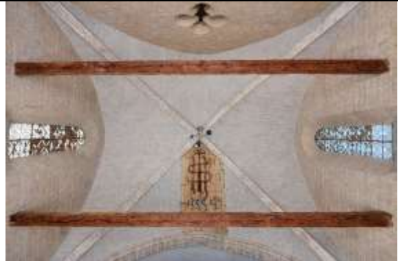
Gewölbedetail des Chors mit restauriertem Putz. Dieses aus dem Jahr 1554 beibehaltende Fragment erinnert somit an eine wichtige Arbeitsphase in der Basilika.
