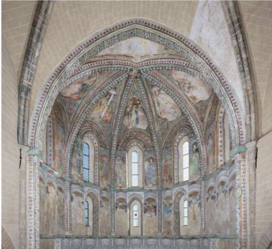
Vue générale du chœur restauré de la Basilique de Valère. Gesamtansicht des restaurierten Chors der Basilika von Valeria. © SIP, Bernard Dubuis et Michel Martinez
