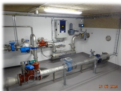
516 : Desinfektion des Wassers mit Hilfe einer UV-Lampe
