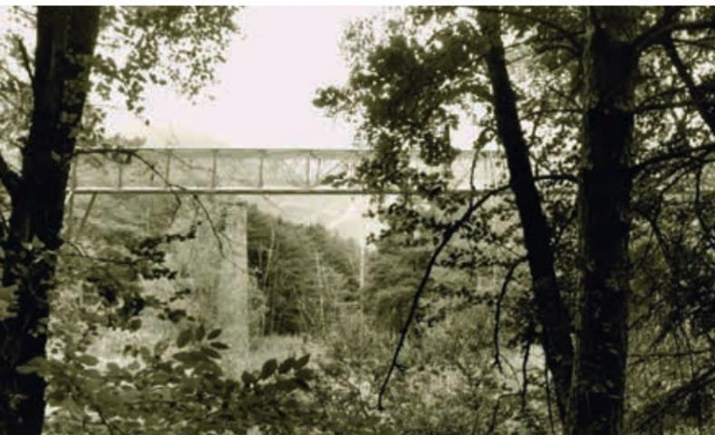
Das neue Projekt beinhaltet eine Passerelle (hier Fotomontage), die die Linienführung der alten Wasserleite nutzt. Diese Passerelle führt über die Weiher, öffnet eine ganz neue Aussicht, ist rollstuhlgängig und verhindert die Störung der Fauna an den Ufern der wiederhergestellten Weiher. Sie integriert sich in den Pfad der Passerellen, welche via Passerelle über den Rotten und der bestehenden Bhutanbrücke von Salgesch nach Leuk führen.
