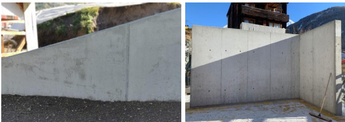
ABB. 5.1 - BEISPIELE FÜR MAUERN AUS RC-C-RECYCLINGBETON: STÜTZMAUER FÜR EINE PRIVATPERSON UND MAUERN EINER SCHULE. Fotos aus Volken Group.
