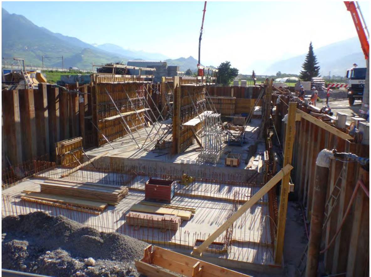
Abb. 4 : ARA Vétroz-Conthey – Betonierung der Vorklärung (Juli 2016)
