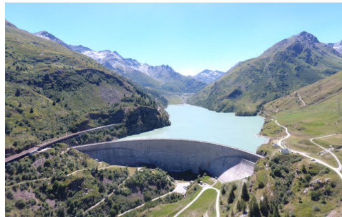
Composante thématique transversale de l'énergie, barrage des Toules, Val d'Entremont
