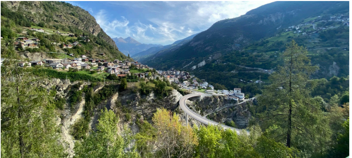
Les vallées latérales avec le coteau forestier et le patrimoine (villages et infrastructures), Stalden, Mattertal
