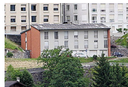
Bâtiment «Marmettes 2», Monthey
