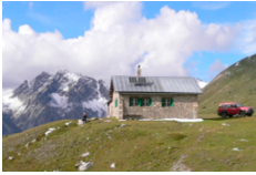
Breitband-Messstation auf dem Ofenpass
