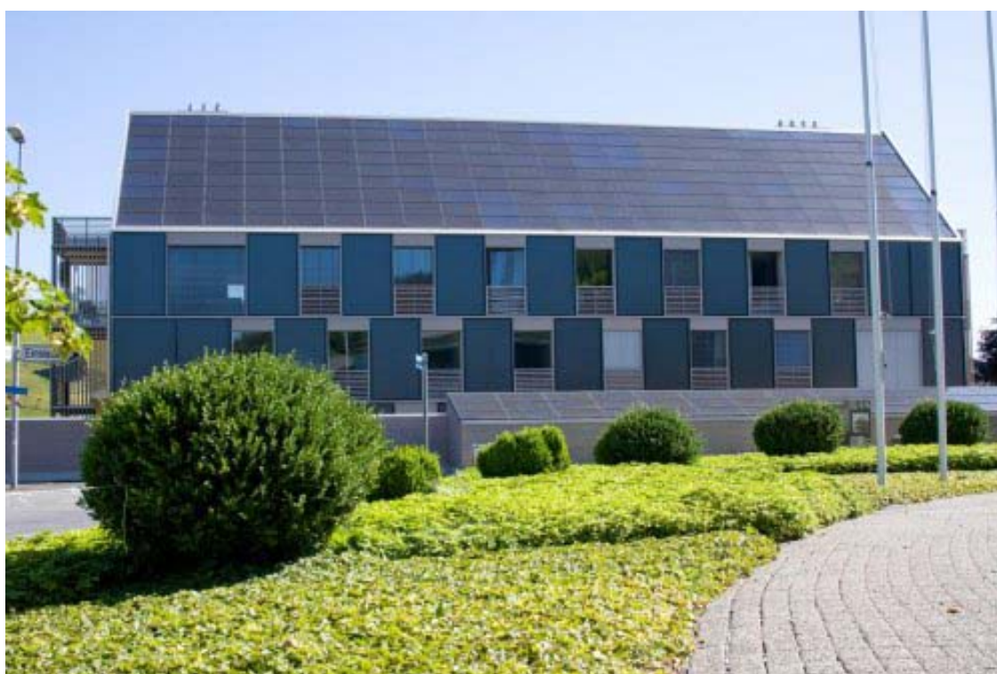
5.5.3 Beispiele einer Dach-PV- und einer thermischen Fassaden-Anlage:
