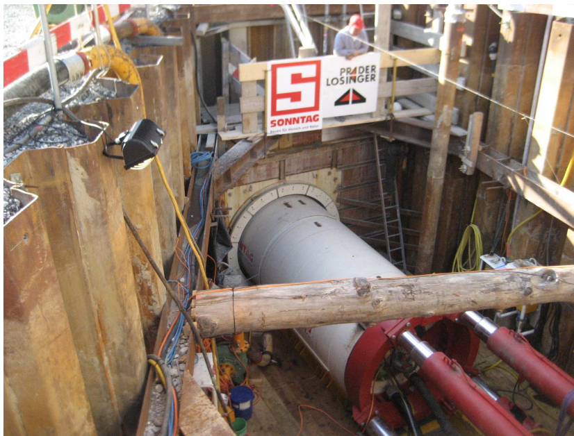
Abb. 7: Stadt Sitten: Bau einer Entlastungsleitung für Fremdwasser durch Microtunneling
