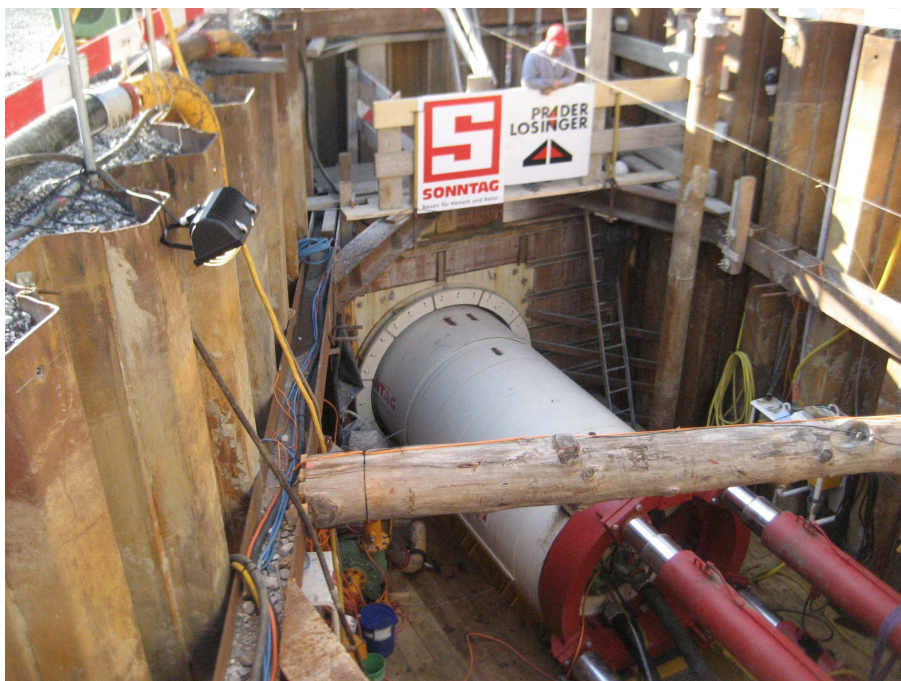
Figure 7 : Ville de Sion : Construction par micro tunnelier d'une conduite d'élimination des eaux claires
