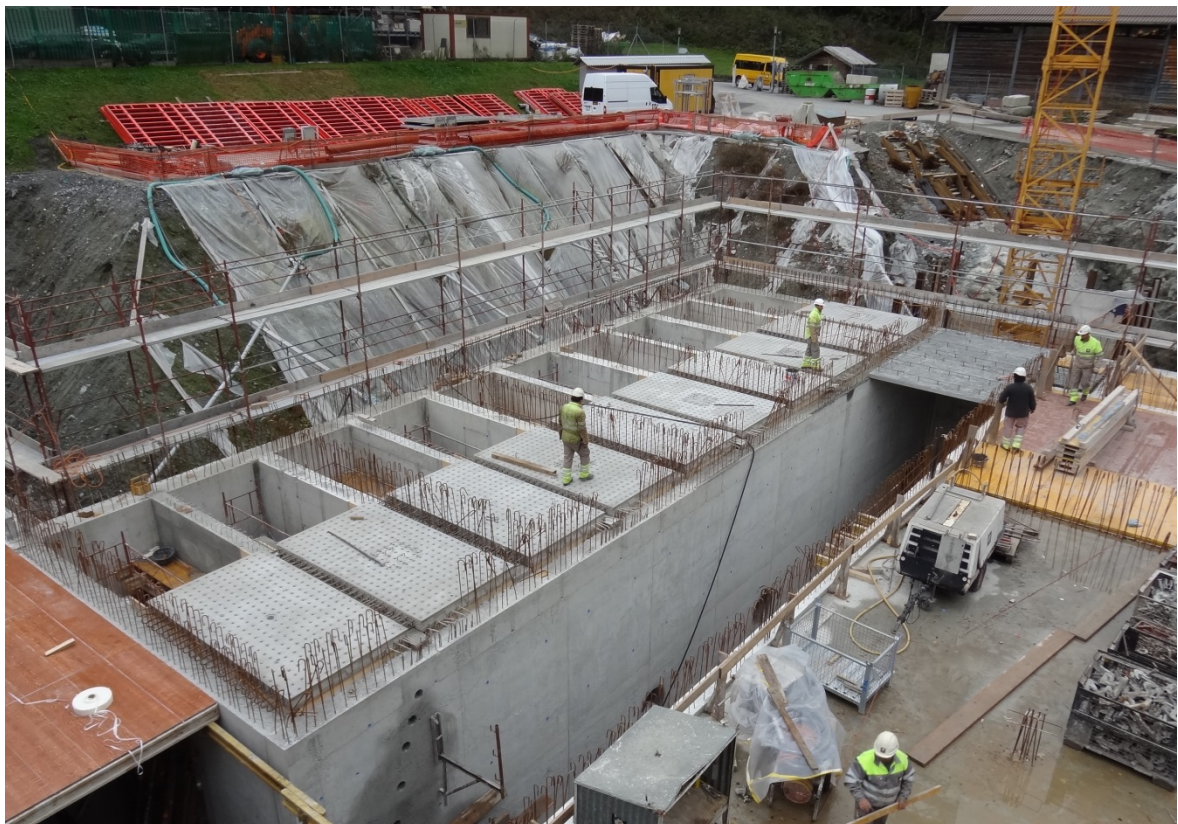
Abb. 6 : ARA Bagnes-Le Châble – Einbau der Decke der Biostyr-Zellen
