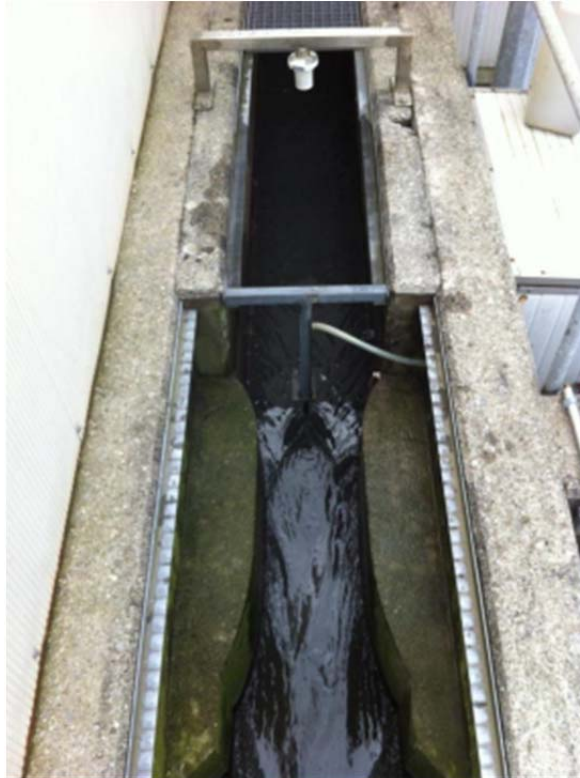
Abb. 9 : Venturi Durchflussmessung Zulauf ARA Collombey-Muraz
