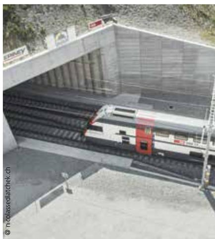
Der neue Gobet-Tunnel ist ein erster Meilenstein zur Modernisierung der Bahnachse Lausanne – Brig. Er wurde so gebaut, dass er von Doppelstockzügen mit 140 km/h durchfahren werden kann. Der Tunnel mit einer Länge von 373 m wurde nach dreijähriger Bauzeit am 29. Juni 2015 offiziell eröffnet.
