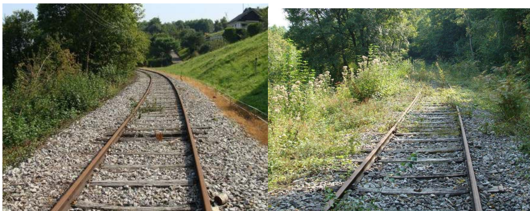
Figure 51 : Etat des rails, du ballast et des traverses en bois
