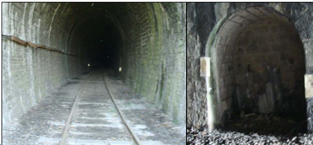
Figure 47 : Niches dans le Tunnel de Meillerie et le Tunnel des Croisettes
