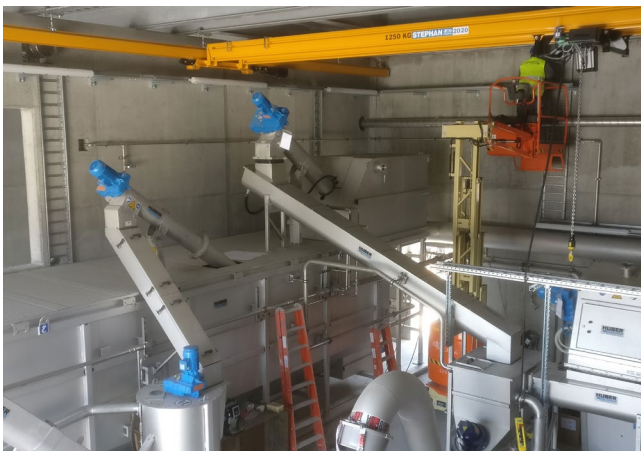
ABB. 11 - ARA COLLOMBEY-MURAZ – NEUES VORBEHANDLUNGSGEBÄUDE
