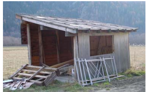
Beispiel 2 Unterstand ohne festes Fundament
