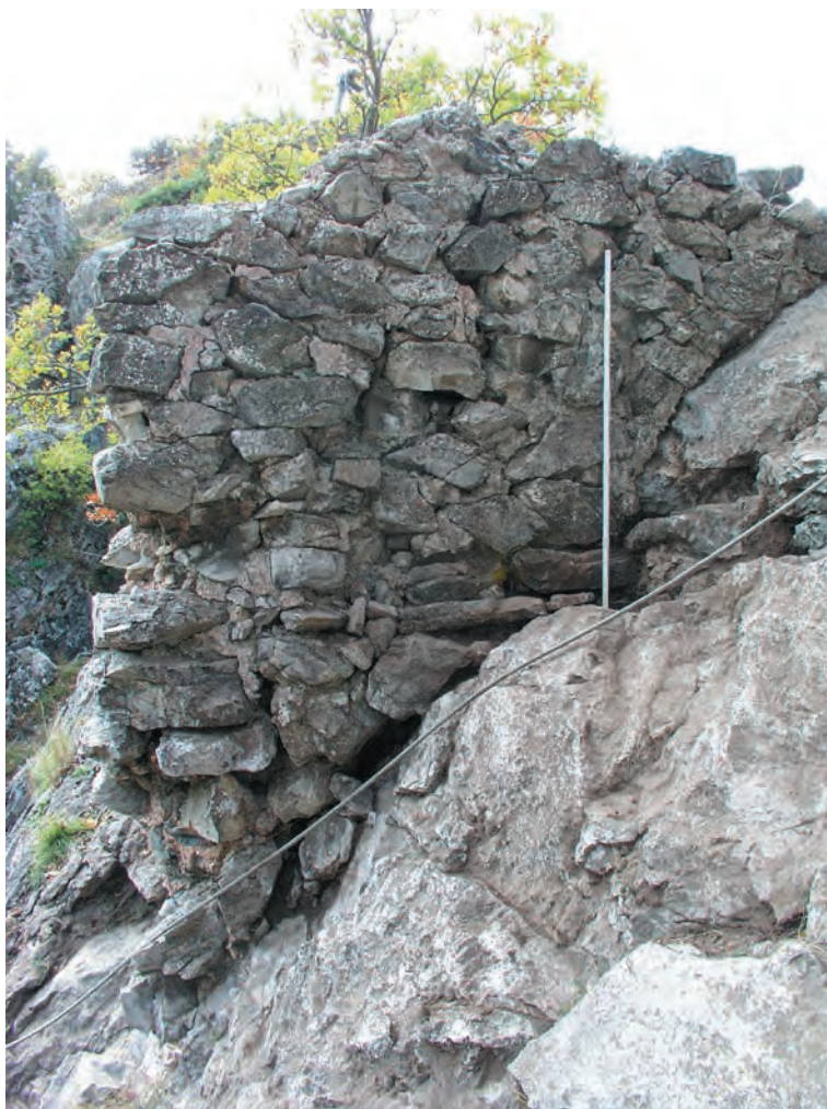
Fig. 10 Le tablier oriental de la passerelle après le nettoyage ....
