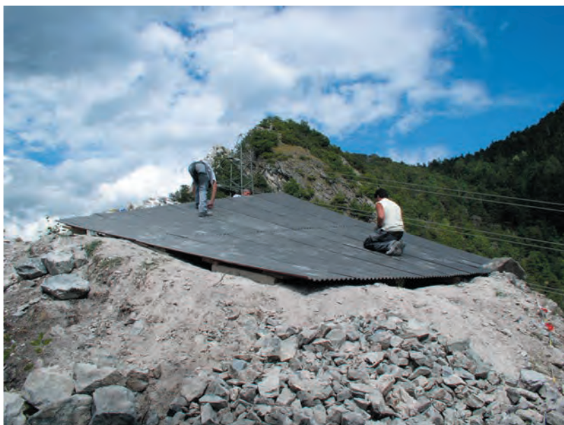
Fig. 14 Couverture provisoire mise en place pour protéger l'escalier en colimaçon. Les tôles ont été boulonnées et lestées de pierres. Vue du sud-ouest.
