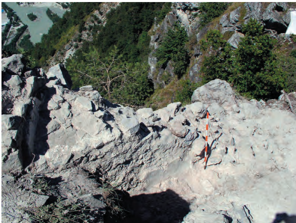
Fig. 17 Mur nord du logis : à gauche, le montant biaisé de l'ouverture orientale (sans doute également une meurtrière asymétrique), à droite, près du jalon, l'angle nord-est du local.
