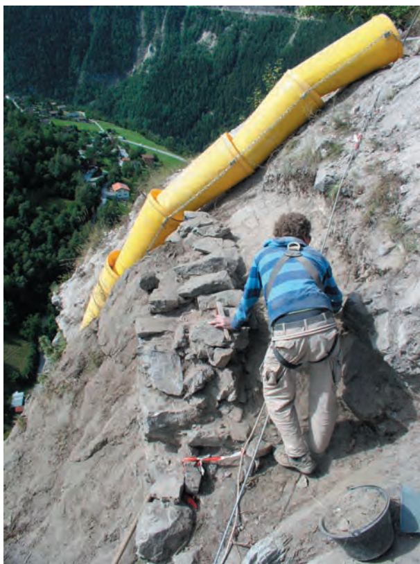
Fig. 3 Dégagement de la chemise orientale. Sur l'arrière, le dévaloir en plastique utilisé pour évacuer les déblais. Vue du nord-est
