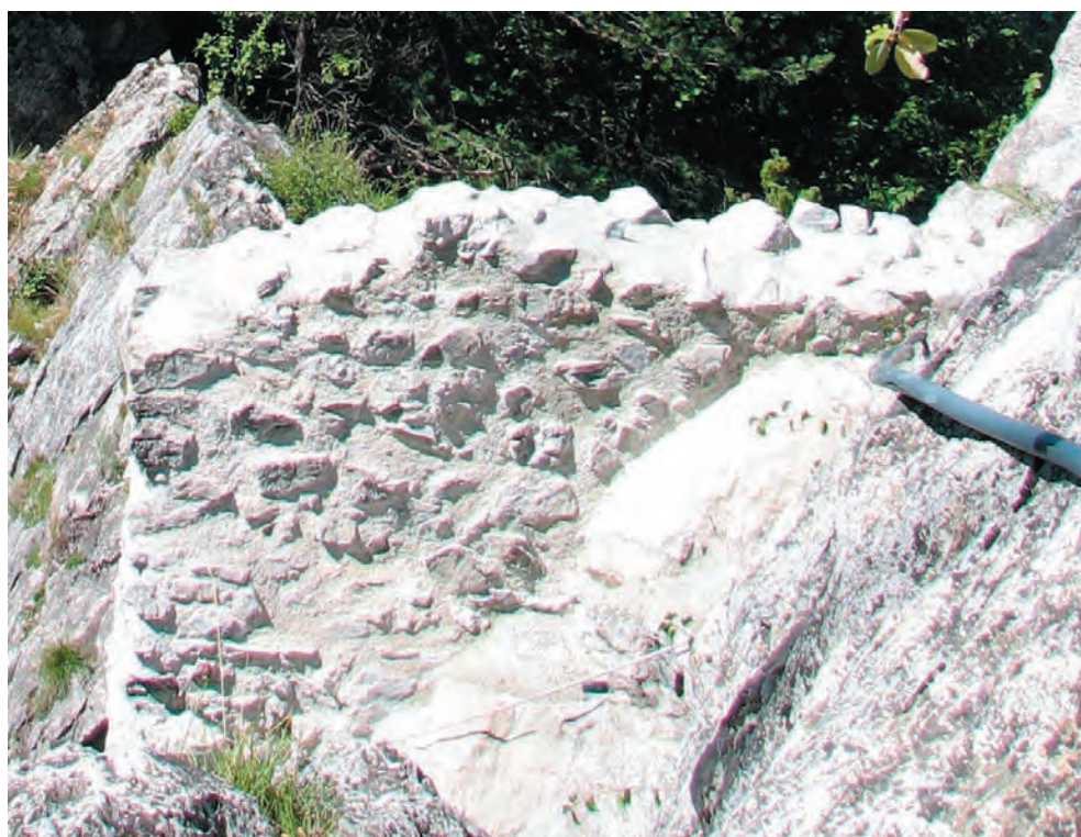
Fig. 11 ... et après sa consolidation. Face orientale.
