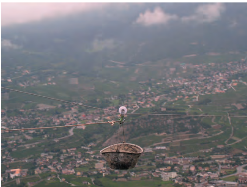
Fig. 4 Transport du mortier de la bétonnière aux vestiges situés à l'est du fossé...
