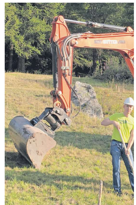
Spatenstich erfolgt. Am Freitagmorgen fiel der Startschuss zum PHOTO: WB
