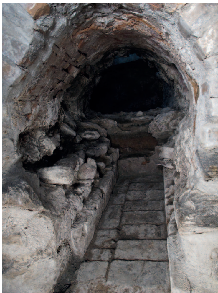
Fig. 22. Sion, Maison du Diable. Détail de l'intérieur du foyer. On distingue le cendrier rectangulaire et la courbure de la voûte en briques. Vue depuis la gueule du four.
