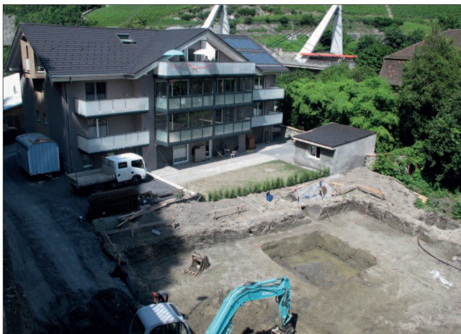
Fig. 12. Saint-Maurice, immeuble Selmonmusaj. Secteur de fouilles et sondage pour l'ascenseur avec les vestiges de la palissade. Vue depuis le sud-ouest. (Photo : TERA Sàrl)
