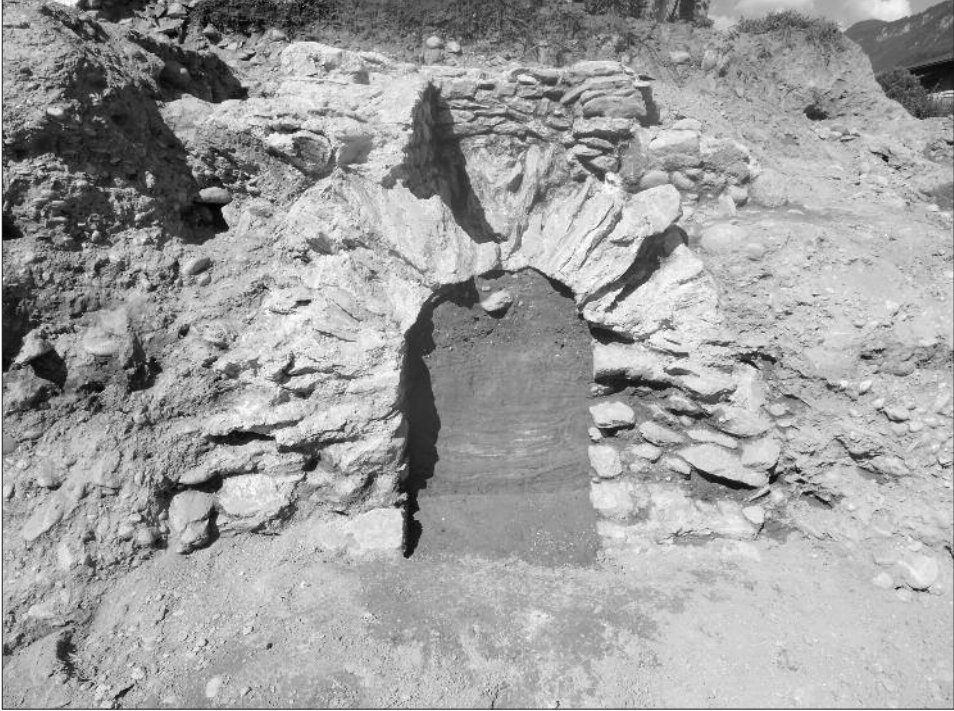
Fig. 6 – Martigny, Forum Claudii Vallensium . Chantier «CV 2013», rue de la basilique . Coupe à travers le regard de l'égout voûté de la rue, aménagé secondairement. De ce fait, la voûte avait été affaiblie. A droite en haut, restes de l'exutoire de la canalisation secondaire provenant de l'espace 79. Vue prise du sud-ouest.
