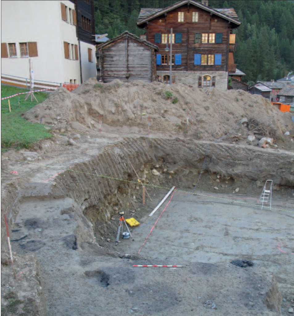
Fig. 16 – Randa, maison Biffiger. La nécropole de Randa a été découverte en bordure d'un chantier de construction. Elle est formée d'une concentration serrée de tombes à incinération, qui se marquent dans le terrain par des taches charbonneuses. Vue depuis le nord-ouest.
