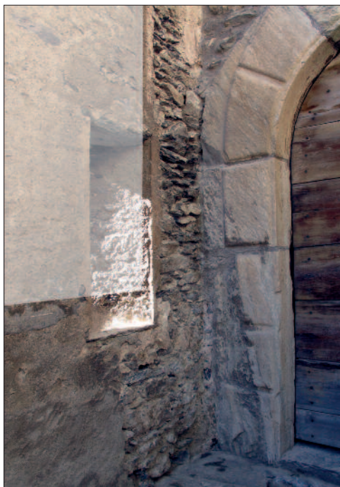
Fig. 31 – Sion, Majorie, galerie d'accès occidentale. Trame claire: ouverture primitive de la paroi sud.
