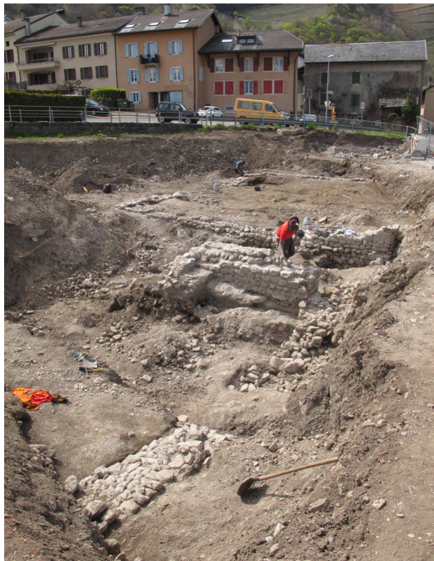
Fig.20 – Au premier plan, le bâtiment B6 adossé contre l'enceinte M17 . Vue en direction de l'ouest. A l'arrière-plan, le bâtiment B5.
