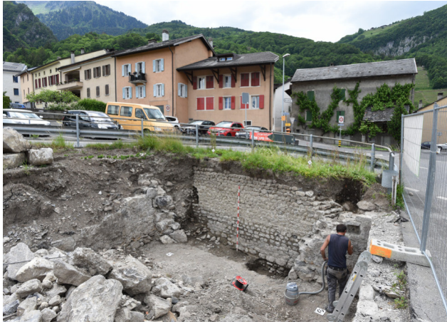
Fig.15 – La façade sud-est du bâtiment B2 est conservée sur une hauteur de 2,20 m. Vue en direction du nord-ouest.
