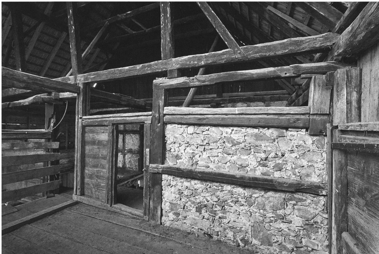
Abb. 56. Mettmenstetten ZH, Grossholzerstrasse 1. Obergeschoss. Rechts der steinerne Speicher, dessen linker Eckpfosten von einem Ständer des Kernbaus von 1432 gebildet wird. Im darüberliegenden Bundbalken zeigen die Blattsassen die ursprünglich flache Dachneigung an. Der aktuelle Dachstuhl stammt von 1682. Foto kantonale Denkmalpflege Zürich.
