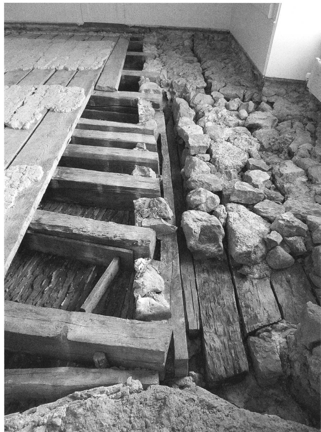
Abb. 57. Murten FR, Schloss. Im Hintergrund die Abbruchkrone. Gut sichtbar die Vormauerung (ab 1255) und der Mörtelgruss des Tonplattenbodens (1735/36). Foto AAFR, Ch. Kündig.
