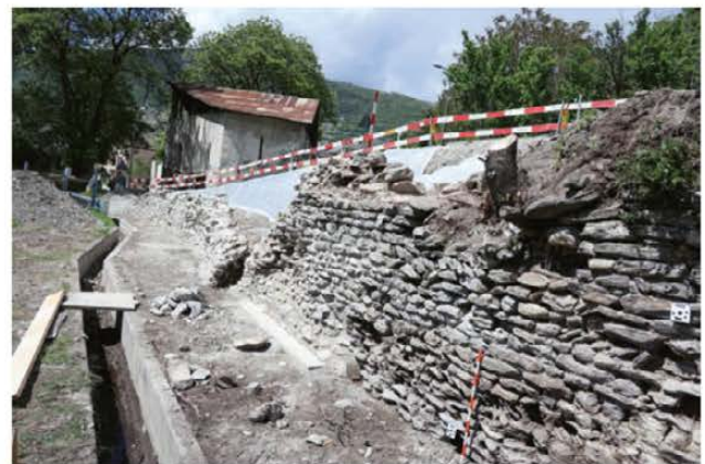
Fig. 73. Sierre VS, Granges. Mur d'enceinte en cours de rénovation. Vue du sud-est. Photo InSitu Archéologie SA, Sion.
