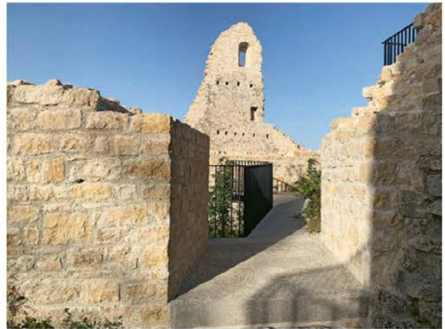
Abb. 53. Buus BL, Farnsburg. Der markante Giebel des so genannten Amtshauses nach der Sanierung. Foto Archäologie Baselland.
