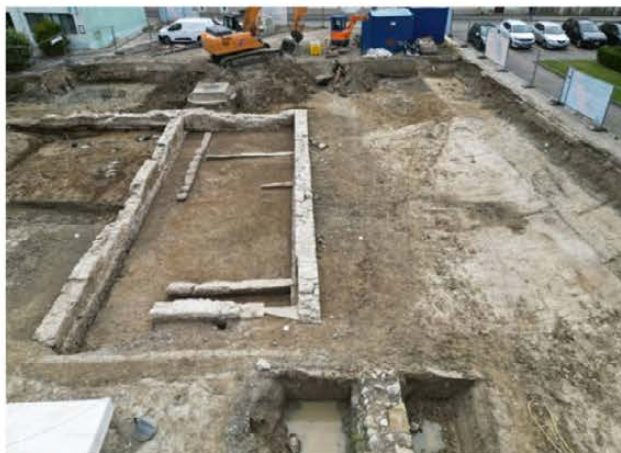
Fig. 84. Payerne VD, Les Rammes. Vue générale vers le sud du bâtiment moderne entièrement mis au jour. Photo Archéotech SA.
