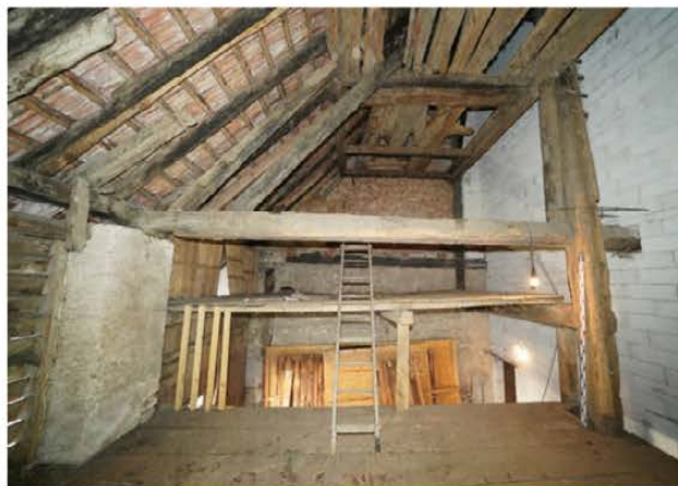
Abb. 82. Oltingen BL, Hauptstrasse 48. Zwei Querbünde der Hochfirstständerkonstruktion. Blickrichtung Osten. Foto Archäologie Bascland.
