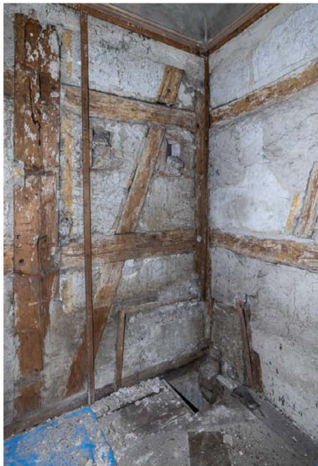
Abb. 77. Aristau AG, Kapfstrasse 24 (Haus Kapf). Detailfoto des bauzeitlichen Aborteinbaus im zweiten Obergeschoss. Zu erkennen sind die beiden Licht-/Lüftungsöffnungen und der Schacht. Der Raum war durch eine Riegelwand (Zapflöcher im linken Bundständer) ausgeschieden und mit einer balkenbetonten Gelbfassung ausgestattet. Bei den Umbauten von 1736 wurde zwar der Raum aufgegeben, offenbar aber der Abort beibehalten, worauf die auf einen entsprechenden «Sitz» Bezug nehmenden Leisten der Tapeten-Leinwand hindeuten. Foto KAAG.
