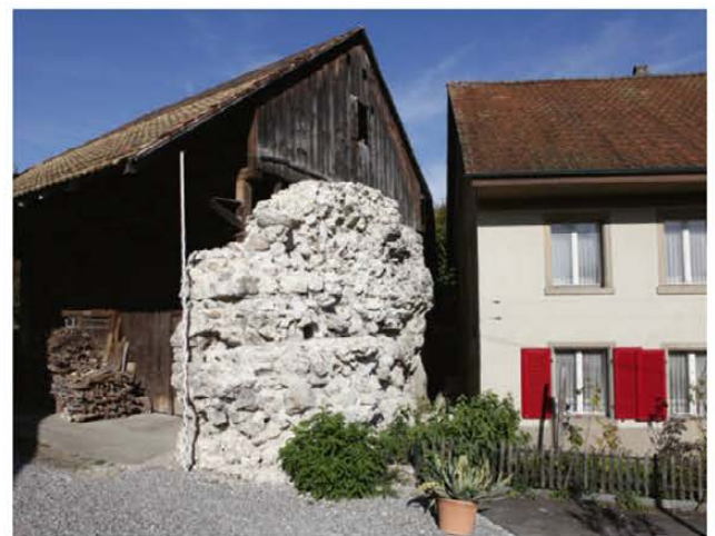
Abb. 29. Brugg AG, Altenburg. Blick von Süden auf einen noch bis zu 4 m hoch erhaltenen Abschnitt der spätrömischen Kastellmauer im Nordosten der Altenburg. Zustand im Herbst 2023 vor Errichtung eines provisorischen Schutzdachs. Foto KAAG.
