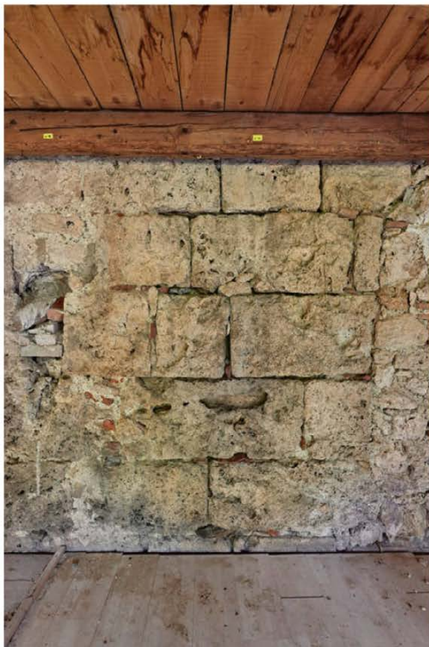
Abb. 55. Eglisau ZH, Obergass 47. Haus «Zum Kloster», Quadermauerwerk der Stadtmauer. Foto F. Fülischer, Winterthur.
