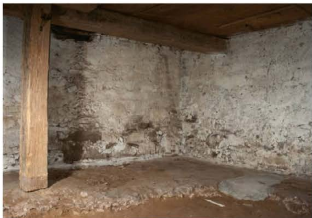
Abb. 32. Filzbach GL, Vordemwald (08.02.E05). Blick auf den teilweise erhaltenen frühromischen Mörtelgussboden im Keller des «Hauses Menzi» (Liegenschaft Kerenzerbergstrasse 102). Im Hintergrund die neuzeitlichen Kellermauern; die flächendeckend erhaltene Substruktion (Bruchsteinkoffer) des frühromischen Mörtelgussbodens (Bildmitte) wird von einer neuzeitlichen/modernen Ausgleichsschicht überdeckt (im Vordergrund). Foto Vindonissa-Professur, T. Westphal.
