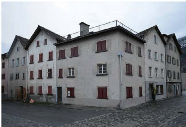
Abb. 80. Domat/Ems GR, Via Baselga 14–18, 20–26. Übersichtsaufnahme der zum Abbruch freigegebenen Häuserzeile. Rechts Haus Nr. 14 und Nr. 16, ganz links Haus Nr. 22. Nach Südosten. Foto AD GR.
