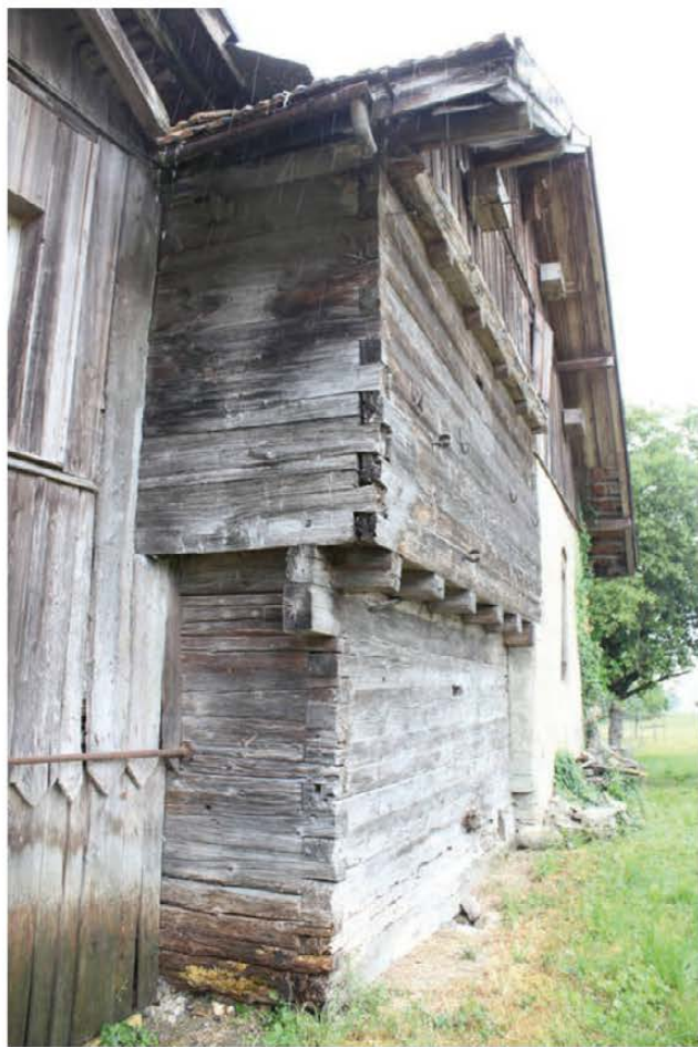
Abb. 81. Märstetten TG, Bahnhofstrasse 49.1. Blockbauspeicher, Erd- und Obergeschoss, im 19. Jh. in eine Scheune eingebaut. Foto Amt für Archäologie TG.
