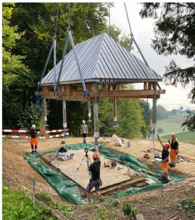
Abb. 88. Salenstein TG, Schloss Arenenberg, Park Ost. Aufstellen des Pavillons auf der wiederentdeckten historischen Bodenplatte. Foto Amt für Archäologie TG.
