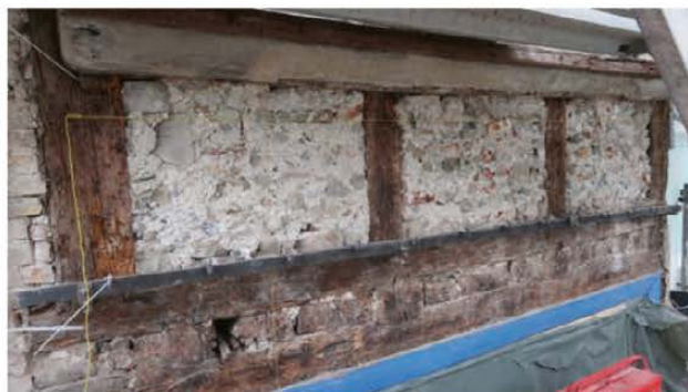
Abb. 95. Zürich ZH, Neumarkt 22. Hofseitige Südfassade, 2. Obergeschoss: Brüstungsbereich mit Fensterbank (nach 1551d), Bodenkonstruktion mit tragendem Balkenrapport und Füllbalken. Foto Stadtarchäologie Zürich.
