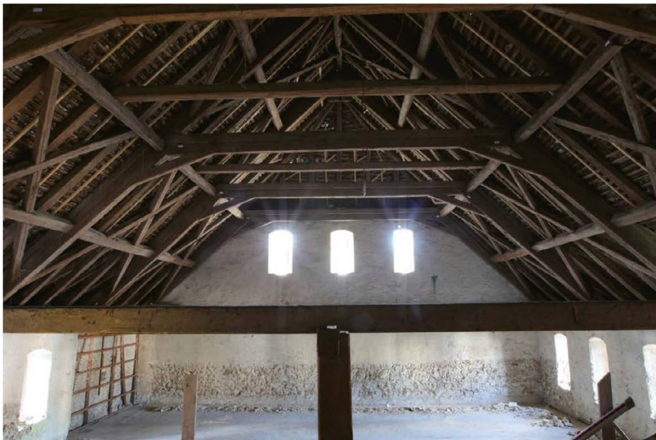
Abb. 79. Dietikon ZH, Kronenplatz 11. Dachkonstruktion der Zehntenscheune von 1756/1757d. Foto KA ZH.
