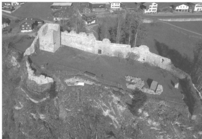
Abb. 49. Luzein GR, Putz, Burganlage Castels. Die von 2011–2014 restaurierten Mauern heben sich deutlich von den noch ungesicherten Partien ab. Blick gegen Norden. Foto AD GR.
