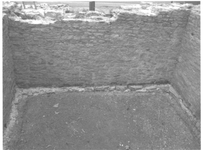
Abb. 21. Koblenz AG, Kleiner Laufen. Blick in die Südwestecke im Inneren des spätantiken Wachturms nach dem Freilegen des Fundamentabsatzes und dem Entfernen der Betonplatten auf der Mauerkrone. Kern und Schale des spätantiken Mauerwerks sind weitgehend erhalten; die Fugen wurden 1932/33 mit Portlandzement ausgestrichen. Foto Vindonissa-Professur Uni Basel, T. Lander.
