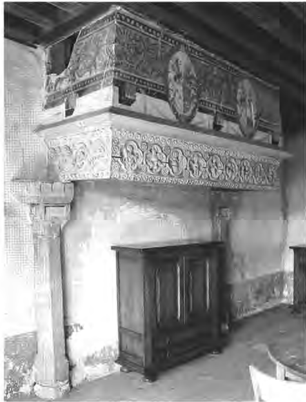
Fig. 49. Rue FR, Maison de Prez-Maillardoz. Salle du deuxième étage, cheminée. Photo SAEF, G. Bourgarel.
