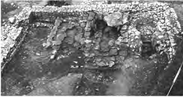
Abb. 40. Zeihen AG, Staufel. Ruine des römischen Gebäudes mit den eingebauten Darren und den darunter liegenden Drainagen. Foto KA AG.
