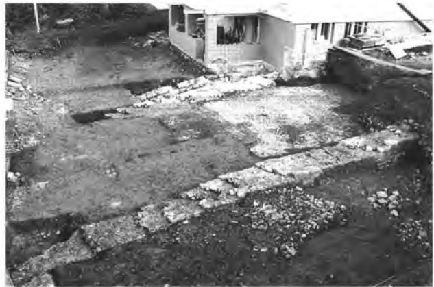
Abb. 20. Augst BL, Augusta Raurica, Südforum (Grabung 2008.053). Übersicht von Südosten. Vorn die fast 1 m breite Mauer, dahinter freigelegt der erwähnte Bauhorizont, ganz hinten beim bestehenden Wohnhaus der Abwasserkanal. Im Hintergrund Mitte römische Mauerzüge, auf die das 1936 errichtete Wohnhaus teilweise fundamementiert worden ist. Foto Augusta Raurica.
