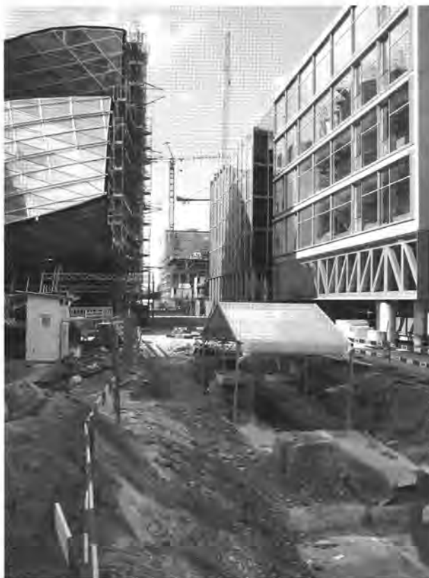
Abb. 12. Basel BS, Gasfabrik, Grabung 2008/7. Fabrikstrasse; Blick nach Norden, unter dem Zelt Reste intakter Schichten zwischen den neu erstellten Campus-Bauten WSJ-242 (Gehry), WSJ-152 (Krischanitz) und WSJ-153 (Monoco). Foto ABBS, A. Jost.
