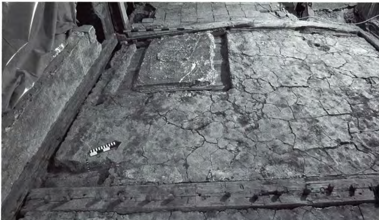
Abb. 48. Zug ZG, St.-Oswalds-Gasse 10. Blick in eine von zwei Stuben im ersten Obergeschoss des 1447 errichteten Ständerbaus. Im Mörtelstrich, der einst unter einem Bretterboden lag, zeichnet sich das Fundament eines Kachelofens aus dem 15. Jh. ab. Foto KA ZG, M. Bolli.
